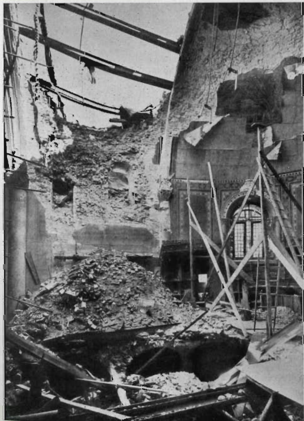
FIG. 2 - MILANO, BASILICA AMBROSIANA - INTERNO DEL CORO SUBITO DOPO IL BOMBARDAMENTO DELL'AGOSTO 1943
