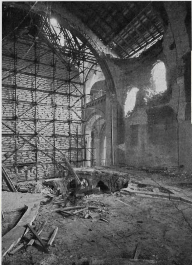
FIG. 3 - MILANO, BASILICA AMBROSIANA - OPERE DI COPERTURA PROVVISORIA COMPIUTE NEL CORO (PRIMAVERA DEL 1944)
