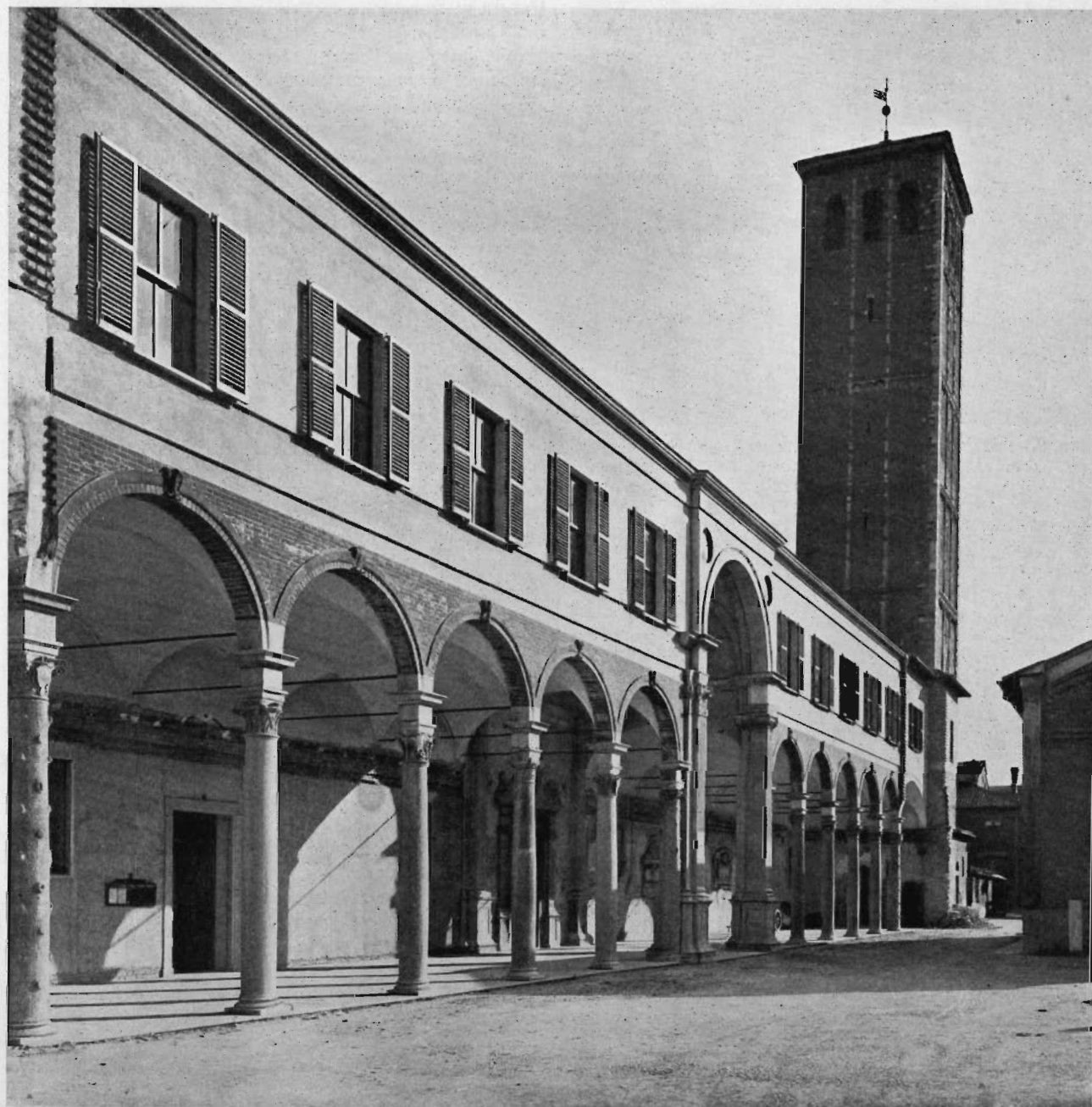
FIG. 7 - MILANO - IL PORTICATO DELLA CANONICA DEL BRAMANTE DOPO LA RICOSTRUZIONE (ESTATE DEL 1949)
