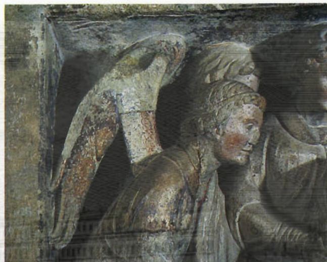
2 - LOSANNA, CATTEDRALE - "PORTAIL PEINT" ARCHITRAVE: PARTICOLARE DI UN ANGELO CON UNA RIPARAZIONE D'ORIGINE DELLA SPALLA
