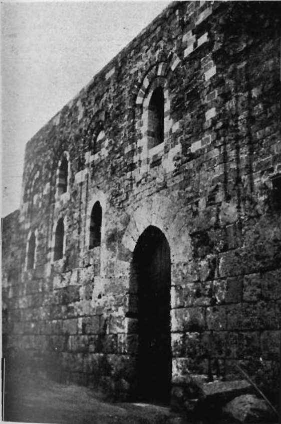
Fig. 26. PALERMO: Chiesetta del Castello Favara. Prospetto principale (dopo il restauro).
