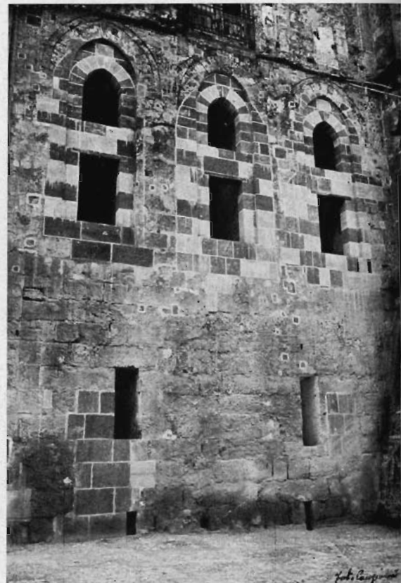
Fig. 25. PALERMO: Palazzo Reale. Zona basamentale dell'edificio normanno (dopo il restauro).
