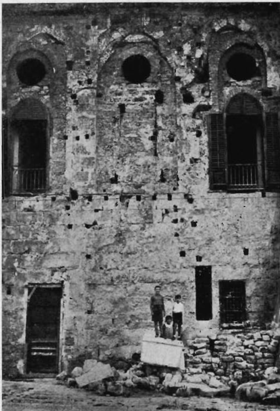
Fig. 24. PALERMO: Palazzo Reale. Strutture normanne esistenti nel prospetto occidentale (prima del restauro).
