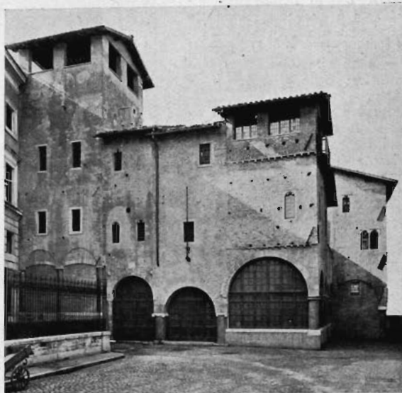
Fig. 7. ROMA: Casette medioevali di San Paolino alla Regola (dopo il restauro).
