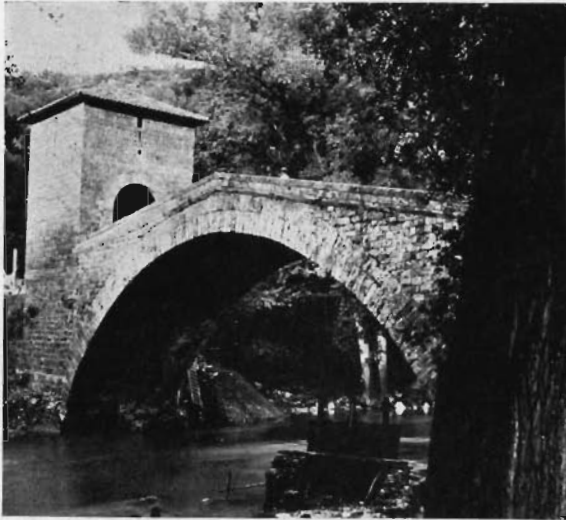
Fig. 8. SUBIACO: Ponte di S. Francesco (dopo il restauro).
