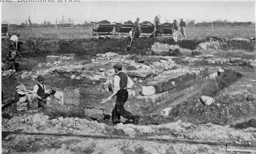
Fig. 2. Il complesso di edifici tardi, durante la prima fase dello scavo.
