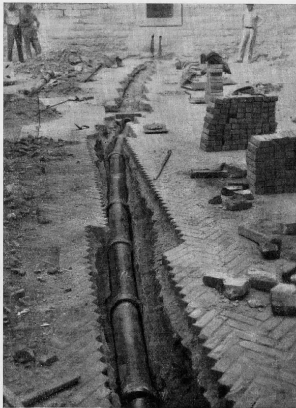
FIG. 4 - GUBBIO, PALAZZO DUCALE: RINNOVAMENTO DELLA CANALIZZAZIONE NEL 1932
