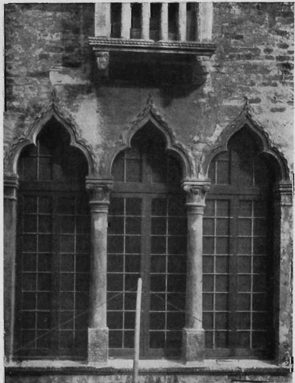
FIG. 6 - VENEZIA - CASA IN RIO DELL'ARCO (PARTICOLARE)
