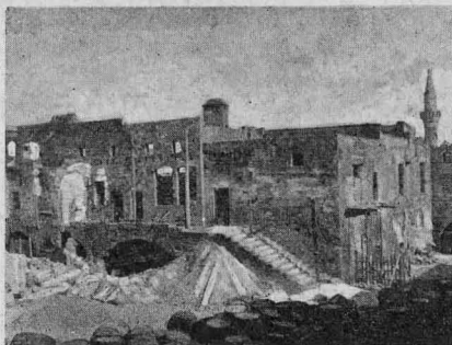
Fig. 9. — Rodi - Albergo d'Alvergnà. (prima dei lavori).
