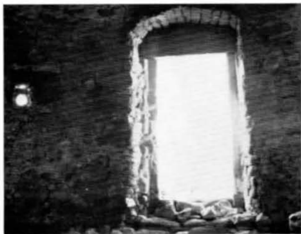
9 - Porta della Torre nord-est, dall'interno
