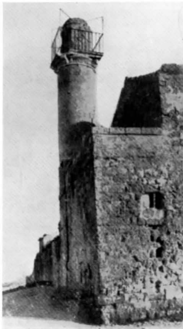
11 - Il distrutto minareto di S. Margherita Belice
