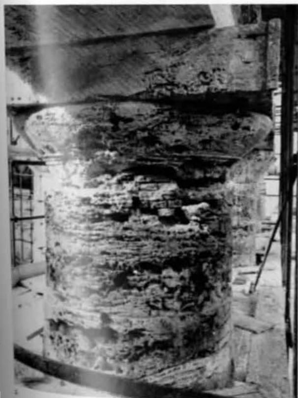
Tempio di Segesta: 1 - Veduta generale con ponteggio tubolare metallico; 2 - Lato Est: colonna con vecchi restauri in mattoni; 3 - Lato Est: colonna con vecchi restauri in pietra calcarea
