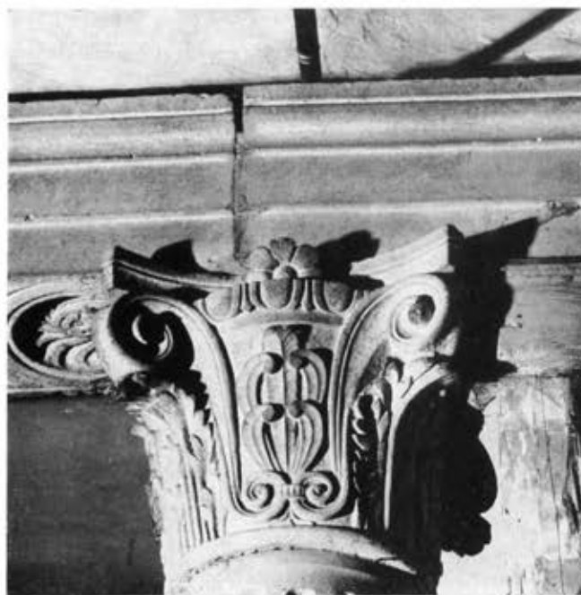
31 e 32 - PESCIA, CHIESA DI SAN FRANCESCO, CAPPELLA CARDINI DETTAGLI DELL'ASSEMBLAGGIO COLONNA-CAPITELLO-ARCHITRAVE Si noti come il giunto risultante dall'accostamento dei due pezzi di architrave non coincide con la mezzeria dei capitelli.
