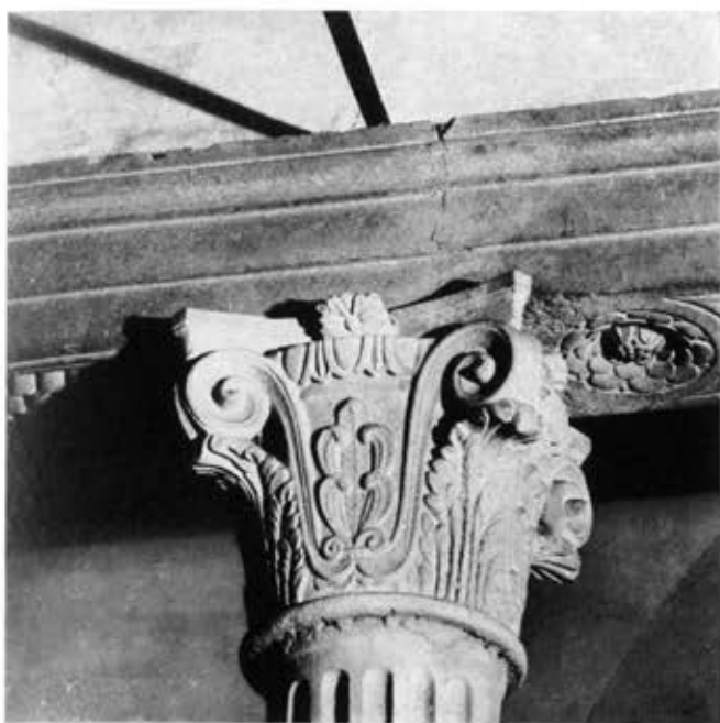
31 e 32 - PESCIA, CHIESA DI SAN FRANCESCO, CAPPELLA CARDINI DETTAGLI DELL'ASSEMBLAGGIO COLONNA-CAPITELLO-ARCHITRAVE Si noti come il giunto risultante dall'accostamento dei due pezzi di architrave non coincide con la mezzeria dei capitelli.
