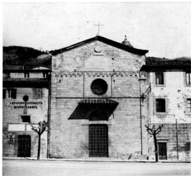
11 - PESCIA, CHIESA DI SAN FRANCESCO - FACCIATA DEL COMPLESSO CONVENTUALE A sinistra (ove si legge "Arciconfraternita di Misericordia") vi è l'ingresso esterno alla Cappella Cardini (originariamente, anche della Cappella degli Orlandi).
