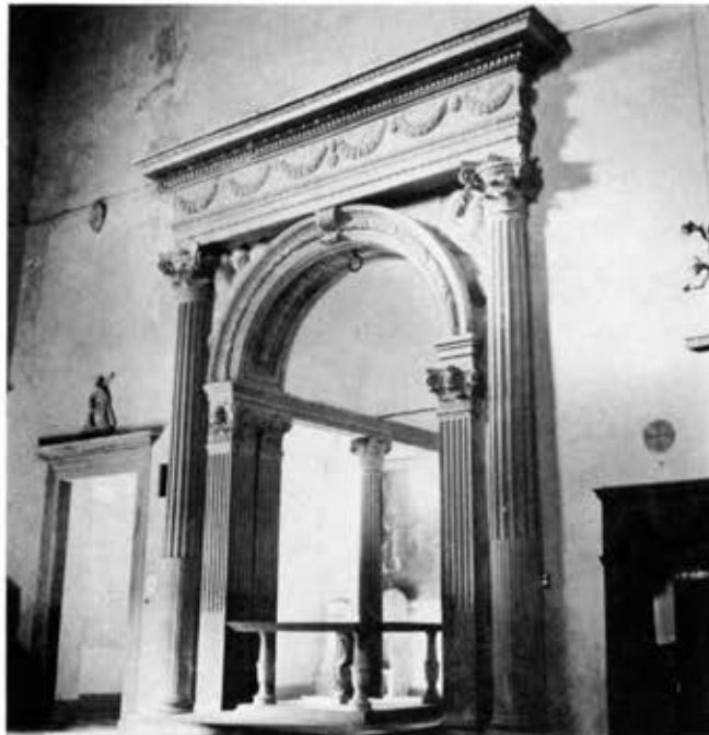
21 - PESCIA, CHIESA DI SAN FRANCESCO, CAPPELLA CARDINI Non è difficile cogliere la continuità percettiva che dall'aula della chiesa si ha verso la Cappella e oltre, attraverso la parete "filtrante" di contenimento.
