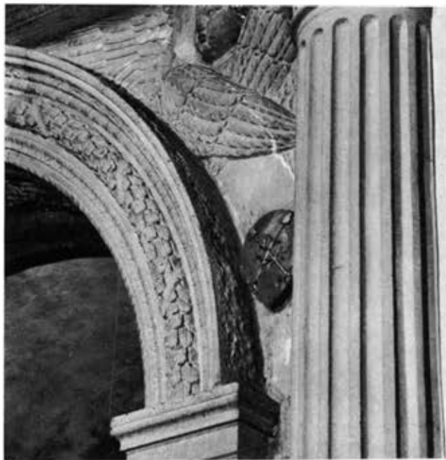
41 - PESCIA, CHIESA DI SAN FRANCESCO, CAPPELLA CARDINI DETTAGLIO DI FACCIATA Il cherubino e l'arme Cardini risolvono plasticamente il triangolo curvilineo fra l'architrave, l'archivolto e la semicolonna.
