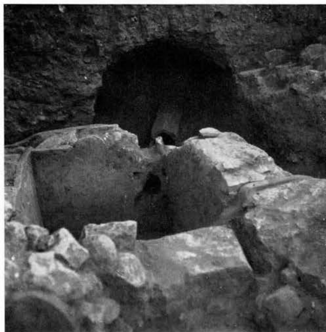
27 - CAMARINA, SAGGIO VIII - IN PRIMO PIANO LA VASCHETTA E SULLO SFONDO LO SCARICO D'ACQUA
