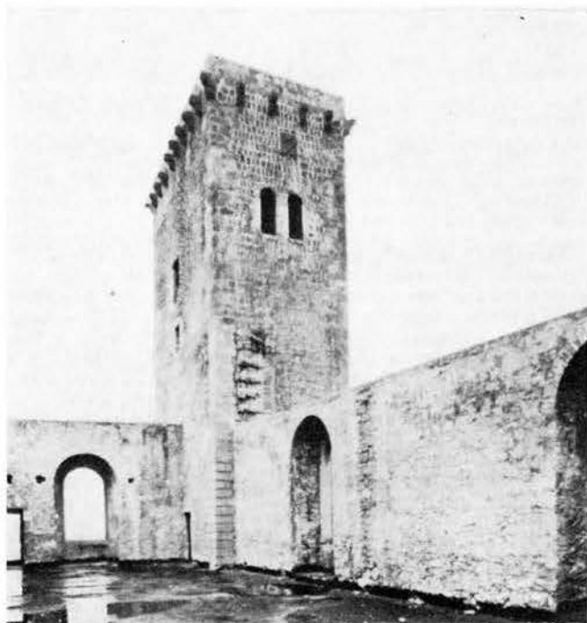
36 - VITERBO, LA ROCCA (Veduta prima della ricostruzione del tetto. Marzo 1970. Si noti sulla torre la traccia della originaria elevazione delle mura perimetrali)
