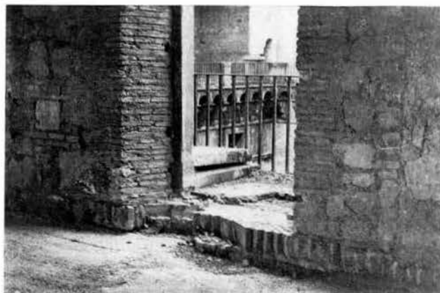
34 - VITERBO, LA ROCCA - RESTI DELLA PAVIMENTAZIONE ORIGINARIA
