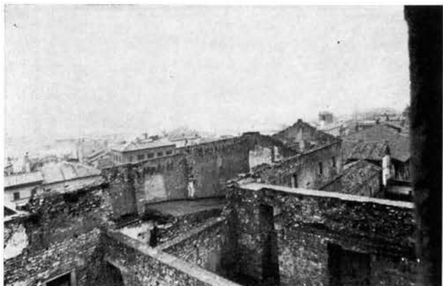
37 - VITERBO, LA ROCCA (Veduta prima della ricostruzione del tetto. Marzo 1970)
