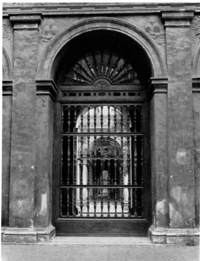
2 - ROMA, PALAZZO SPADA - CORTILE GRANDE CANCELLO FISSO IN LEGNO A BALAUSTRINI TORNITI (foto Savio, Roma)
