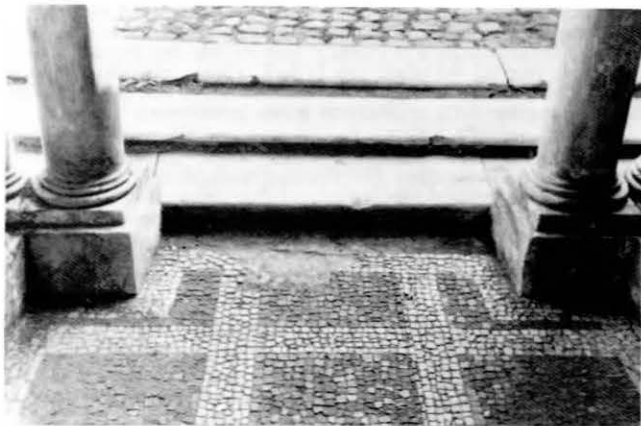
24 - ROMA, PALAZZO SPADA - FRANCESCO BORROMINI: GALLERIA PROSPETTICA, PAVIMENTAZIONE A MOSAICO E GRADINI TERMINALI DELLA GALLERIA PROSPETTICA PRIMA DELLE RECENTI MANOMISSIONI
