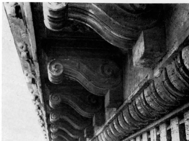
I - ROMA, PALAZZO FARNESE - PARTICOLARE DEL CORNICIONE (foto O. Michel)
