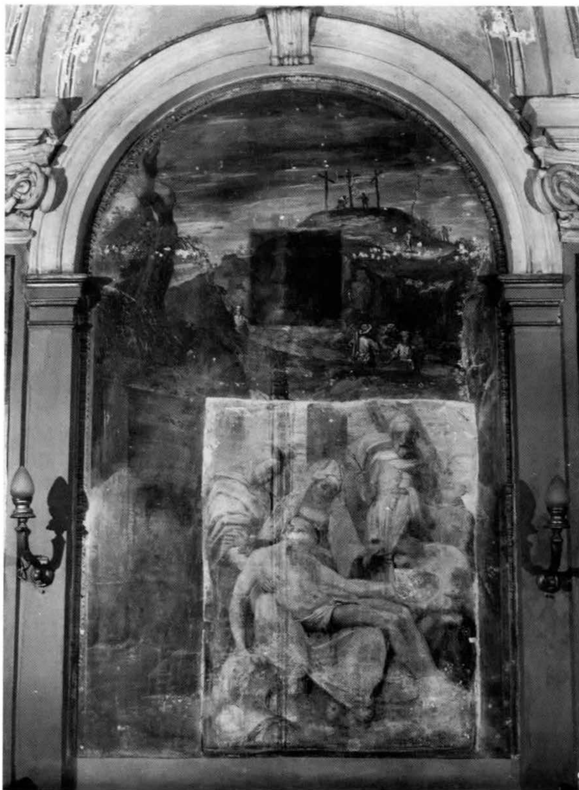
4 - ROMA, CHIESA DI SANTO STEFANO DEL CACCO, NAVATA DESTRA - PERIN DEL VAGA (ATTRIBUITO): PIETÀ L'affresco è stato restaurato nel 1961 a cura della Soprintendenza per i Beni Ambientali e Architettonici. Il perdurare dell'umidità di risalita, che interessa le varie parti della chiesa, ha causato il ripresentarsi di estese chiazze biancastre tipiche della fuoriuscita dei sali.
