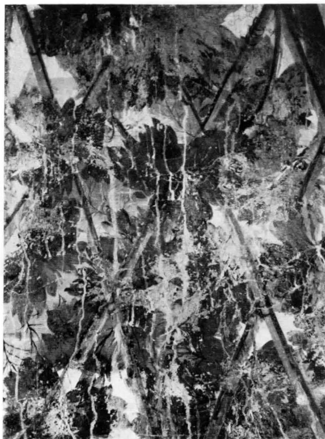
14 - ROMA, VILLA GIULIA, VOLTA DELL'EMICICLO (PARTICOLARE) Concrezioni di carbonato dovute a condensa di umidità sopra la superficie.
