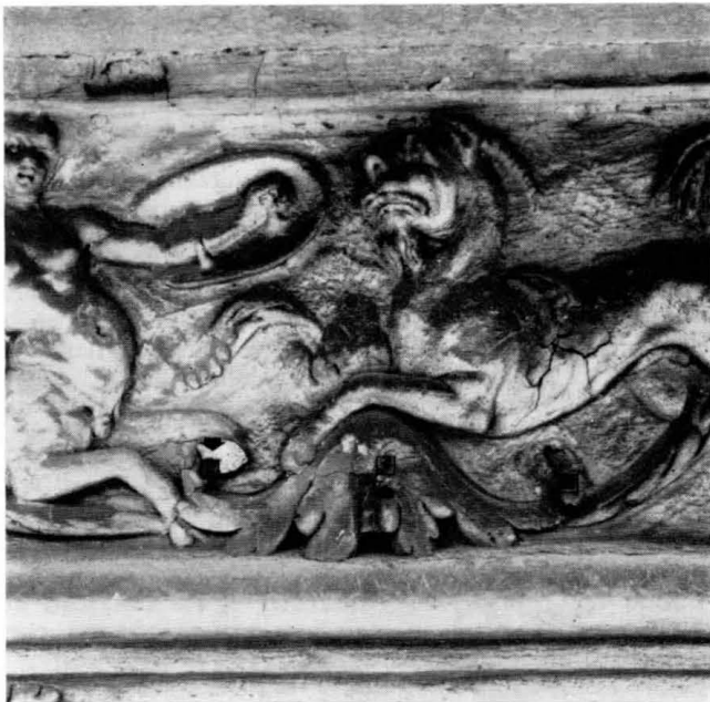
17 - ROMA, VILLA GIULIA, PRIMO CORTILE, TERZA NICCHIA DEL LATO DESTRO - PARTICOLARE DEL FREGIO Si notano i chiodi di sostegno del modellato che, rigonfiandosi, hanno spaccato lo stucco.
