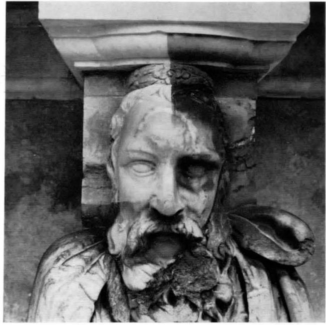
23 - ROMA, VILLA GIULIA, PRIMO CORTILE FACCIATA DI FONDO PARTICOLARE DEL SECONDO TELAMONE Particolare durante la pulitura a microsabbatura.
