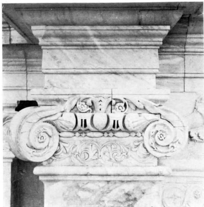
19 - ROMA, VILLA GIULIA, PRIMO CORTILE, FACCIATA DI FONDO PARTICOLARE DI CAPITELLO Il capitello di lesena appare realizzato con due pezzi di marmo giuntato.
