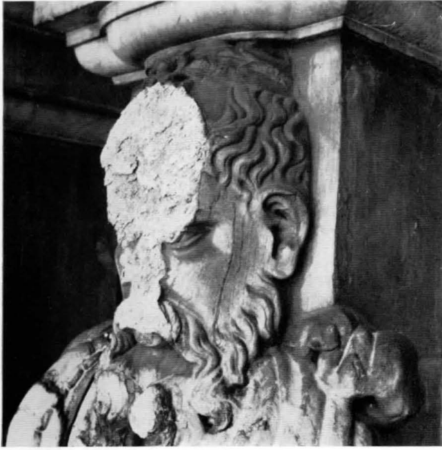
22 - ROMA, VILLA GIULIA, PRIMO CORTILE, FACCIATA DI FONDO PARTICOLARE DEL VOLTO DEL PRIMO TELAMONE A SINISTRA Si nota la defoliazione del marmo lungo una delle sue linee di scistosità.
