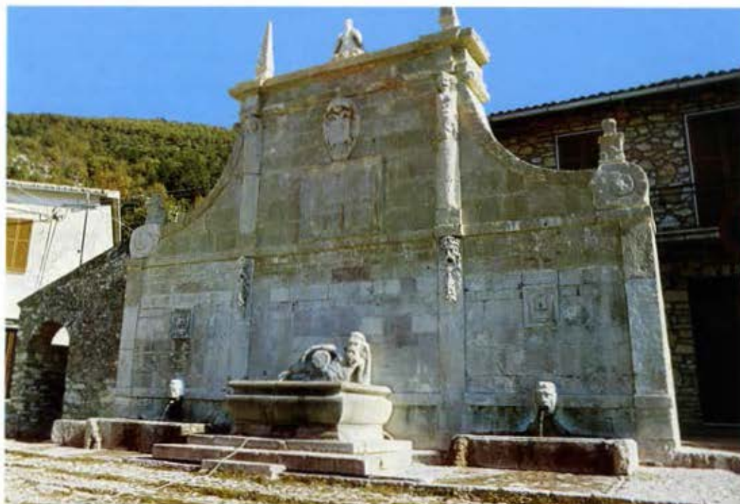
a) POLINO (TERNI) – FONTANA MONUMENTALE, DOPO I LAVORI DEL PRIMO LOTTO Notare la differenza tra la parte trattata (la superiore) e quella inferiore ancora da trattare.
