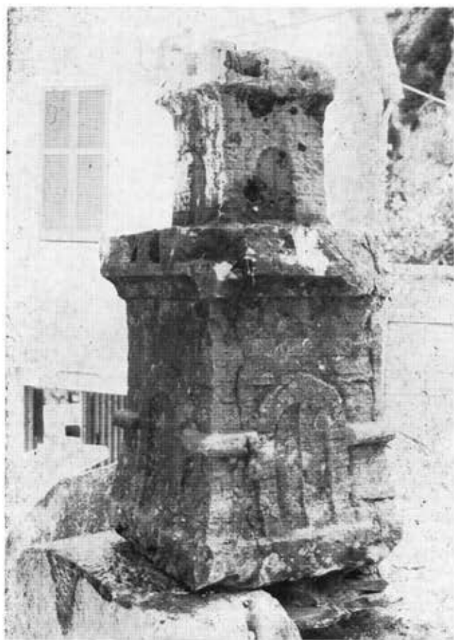
POLINO (TERNI), FONTANA MONUMENTALE - PARTICOLARI DELLO STATO DI CONSERVAZIONE PRIMA DEI LAVORI DI RESTAURO 17) UNA DELLE TORRETTE (SINISTRA); 18) COPERTINA DELLA FONTANA
