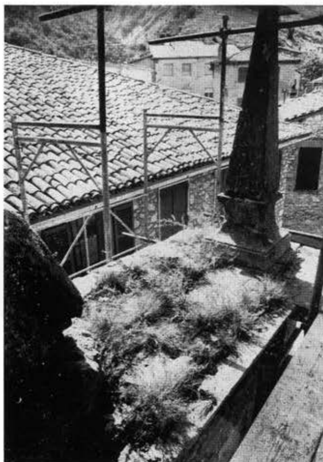
POLINO (TERNI), FONTANA MONUMENTALE - PARTICOLARI DELLO STATO DI CONSERVAZIONE PRIMA DEI LAVORI DI RESTAURO 17) UNA DELLE TORRETTE (SINISTRA); 18) COPERTINA DELLA FONTANA
