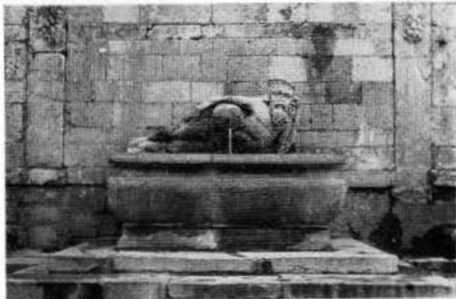
7 - POLINO (TERNI), FONTANA MONUMENTALE - PARTICOLARE CON LA VASCA CENTRALE ED IL MARFORIO Notare la vistosa stuccatura in cemento sul capo.
