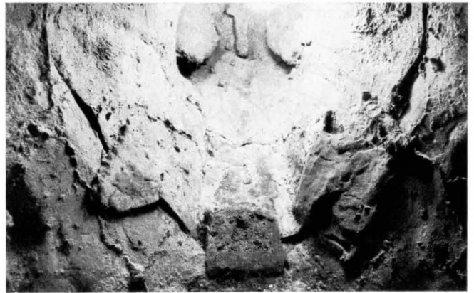
6 - INTERNO DELLA TESTA CARAFA: ZONA DI GIUNTURA DEL MUSO Si notano quattro pezze in bronzo utilizzate per l'aggancio.
